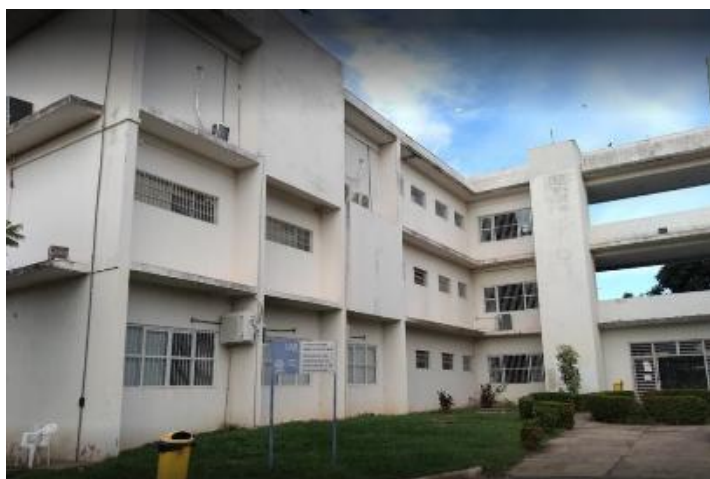
Figura 7: Infraestrutura predial da SETEC – UFMT.
