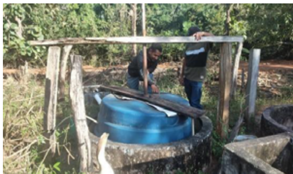
Figura 1 – Tanque de Armazenamento do Biodigestor
